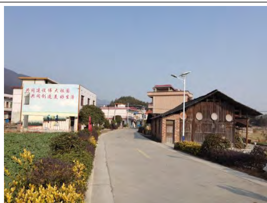
图 13-1 玉屏村改造点现场图
